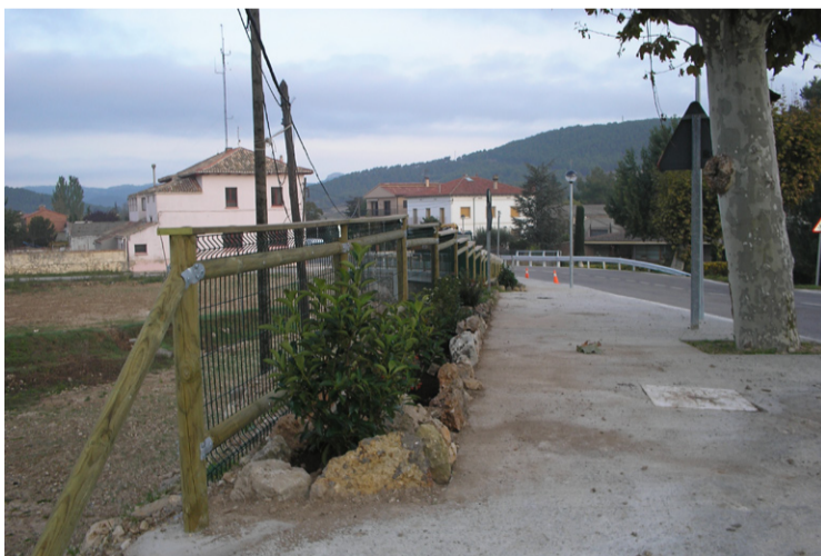
El nou pont dels bombers millora l'entrada a la Llacuna
